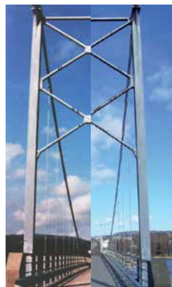
Мост Калвойя (Kalvøya) в Норвегии был обработан покрытием ZINGA® в 1985 году. Спустя 30 лет мост по-прежнему находится в хорошем состоянии.
